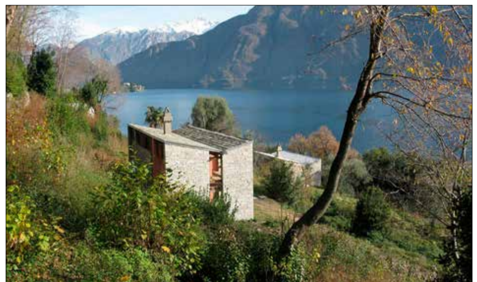
Renovatie van de kunstenaarswoningen op het eiland Isola Comacina, Comomeer (IT).
