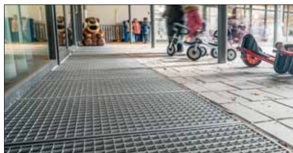
Bij de ingang waar de kinderen vanuit de speelplaats het gebouw betreden, werd gekozen voor de CleanBox, een modulaire afwaterende deurmat.
