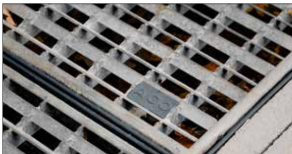
Het antislip v-rooster zorgt dat alle vuil afkomstig van kinderschoentjes achterblijft in de onderliggende vloerbak.
